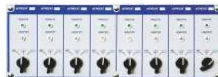
Панель ручного управления 8-ю насосными агрегатами
