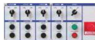
Пульт ручного управления четырьмя насосными агрегатами и четырьмя напорными задвижками
