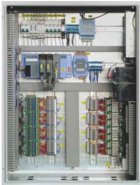
Блок телеметрии СТА1714 предназначен для построения систем телеметрии и автоматизированных систем диспетчерского контроля и управления. Является объектно-ориентированным.
