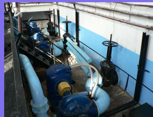
4. На НС 3-го подъема («Петровская») построен дополнительный резервуар на 1000 м<sup>3</sup> и на подающих трубопроводах в резервуары установлены дисковые затворы с электроприводами.
